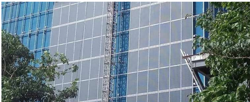
ภาพที่1 อาคาร CTRLS Data center ประเทศอินเดีย กำลังติดตั้งผนังเซลล์แสงอาทิตย์
