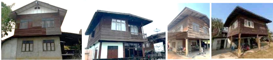
ภาพที่ 9 บ้านครึ่งไม้ครึ่งปูนลักษณะแรก (ต่อเติมใต้ถุน)
