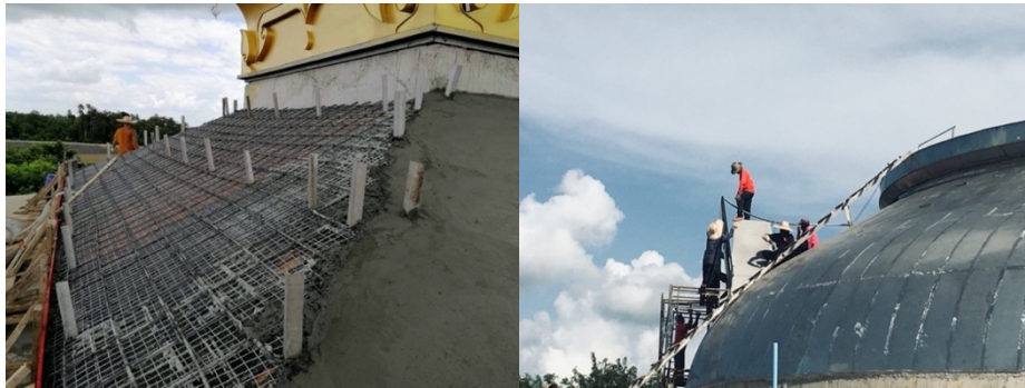
ภาพที่ 8 ภาพการถักโครงสร้างหุ้มผิวพระธาตุเกษแก้วและบุผิวด้วยสแตนเลส ที่มา: พระทรงวิทย์ แจ้งจิตร (2562)
