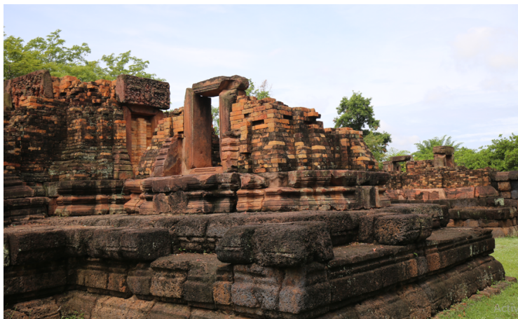
ภาพที่ 12 ร่องรอยการก่อพอกขยายฐานไฟที่ทุกด้านปิดทับฐานบัวด้านใน
