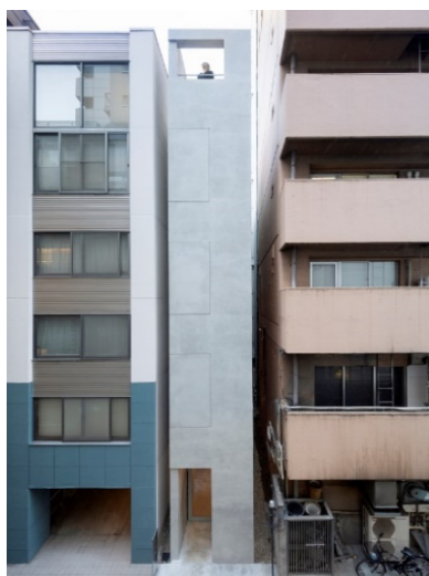
ภาพที่ 14 Multi-Tenant Building In Ginza
