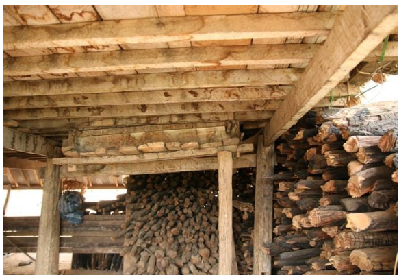
รูปที่ 16 รูปแสดงลักษณะโครงสร้างพื้นและโครงสร้างรองรับแม่เตาไฟ
