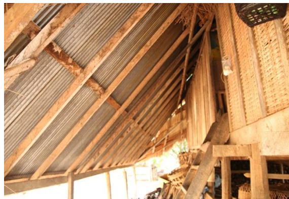
รูปที่ 14 รูปแสดงลักษณะโครงสร้างหลังคา
