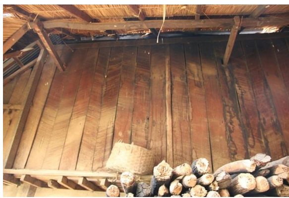
รูปที่ 15 รูปแสดงลักษณะโครงสร้างผนังไม้และฝาไม้ผสมฟาก
