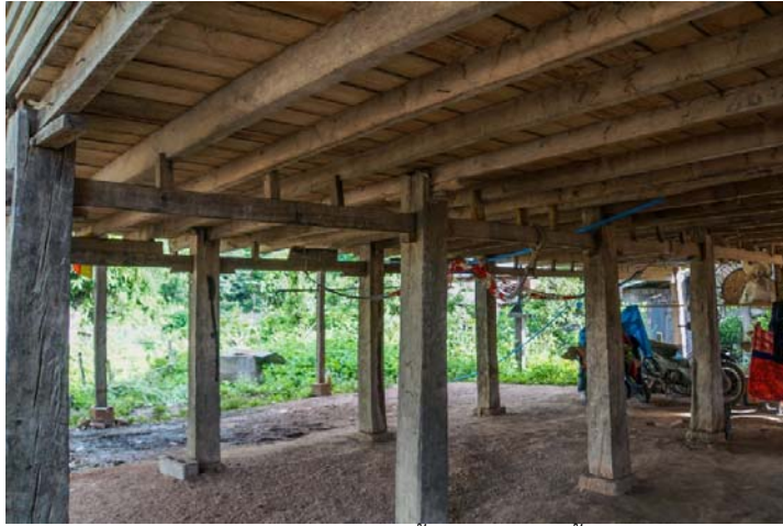
ภาพ 22 โครงสร้าง วาง ตง พื้น ของเรือนไต้ลื้อเมืองสิง
