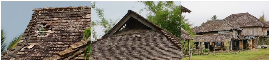
ภาพ 9 ร่องรอยความเสียหายของหลังคาจั่ว และการปรับรูปเป็นหลังคาปั้นหย่า
