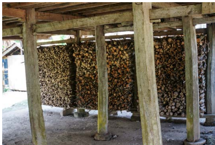
ภาพ 14 เสาตั้งบนหินและโครงสร้างพิเศษกันเรือนเซ
