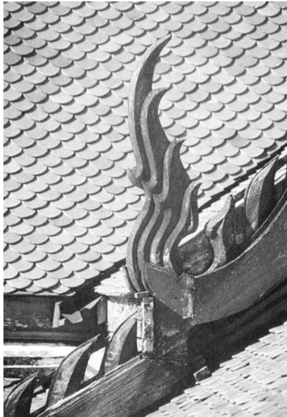
ภาพที่ 20: ทางหงส์ประดับเครื่องบน หลังคาของหัตถศิลป์ กรมศิลปากร ทางหงส์ปากปลา ประดับเครื่องบนหลังคาของหัตถศิลป์ กรมศิลปากร
