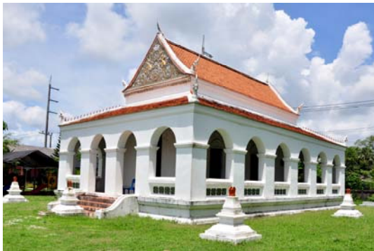
ภาพที่ 7: อุโบสถแบบพื้นถิ่นวัดสี่หยัง อำเภอรโนด จังหวัดสงขลา
