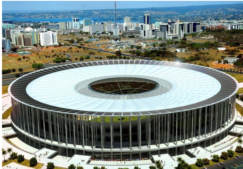
ภาพที่ 4: The new soccer stadiums ในประเทศบราซิล เพื่อใช้ในการแข่งขันฟุตบอล World Cup 2014 แสดงการใช้ผืนหลังคาผ้า (Fabric) ที่ฉาบผิวด้วย \text{TiO}_2
