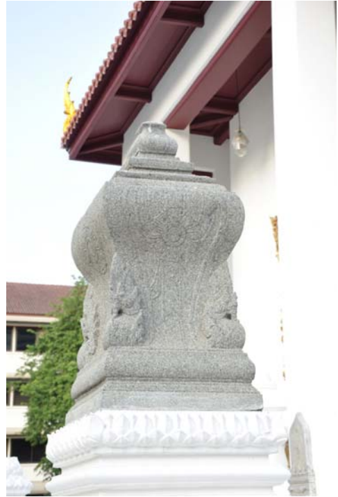
ภาพที่ 5: แสดงหลักมหาสีมาชั้นในรอบพระอุโบสถ วัด ปทุมวนารามถ่ายจากทิศตะวันตกเฉียงใต้
