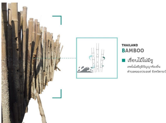
ภาพที่ 12: ลักษณะเขื่อนไม้ไผ่เจาะช่อง ที่มา: ผู้วิจัย
