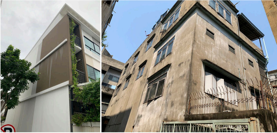
ภาพที่ 9: แสดงลักษณะผนังภายนอกอาคาร
