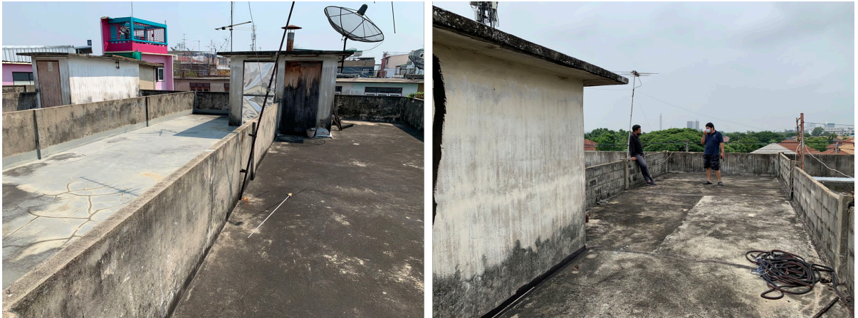
ภาพที่ 11: แสดงลักษณะดาดฟ้าอาคาร
